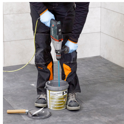
Bland grundigt. For at sikre at blandingen bliver homogen, skal materialet hældes i en anden beholder og omrøres igen.
