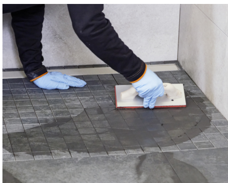
Meget let fugning uden restslør med PCI Durapox Premium.
