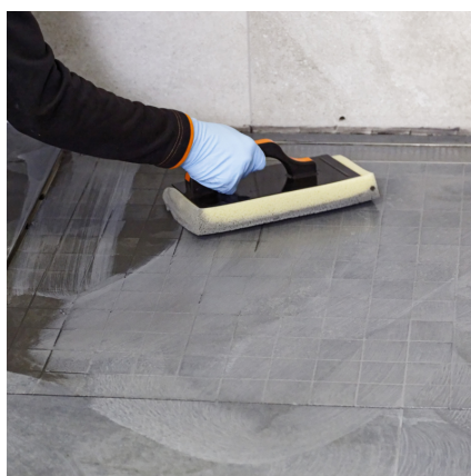
Efter ca. 10-45 min. emulgeres den fugede flade med et svampebræt og vaskes ren.
