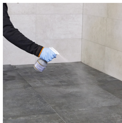
Efter ca. 60 min. og inden den afsluttende afvaskning sprøjtes PCI Durapox Finish (flydende) på fladen.
