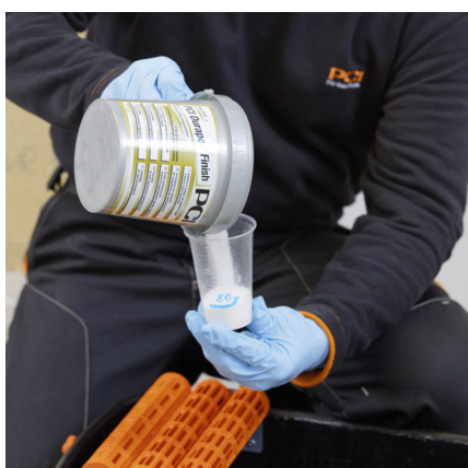
Alternativt kan der også hældes PCI Durapox Finish (koncentrat) i blandingsforholdet 1:100 – dvs. 50 g Durapox Finish til 5 l vand – direkte i vaskevandet.
