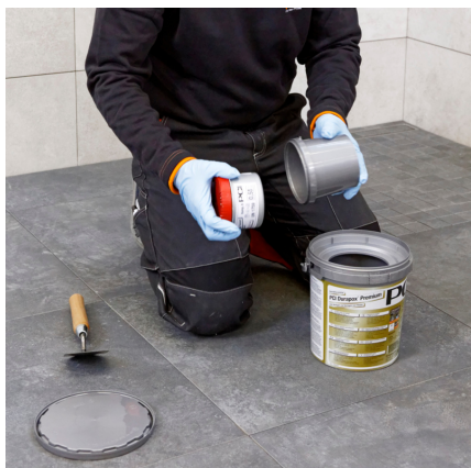
Åbn PCI Durapox Premium (Multicolor) (2 kg), og tag den anden komponent ud.
