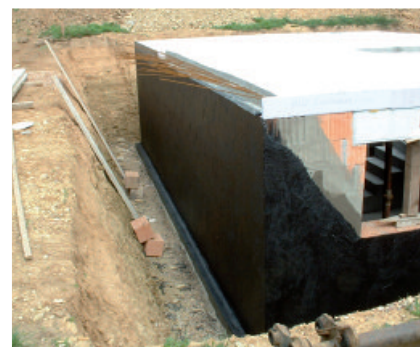
Tætning af en kældervæg af beton udvendigt med PCI Pecimor 2K. Let og smidig forarbejdning takket være polystyrolfyld.
